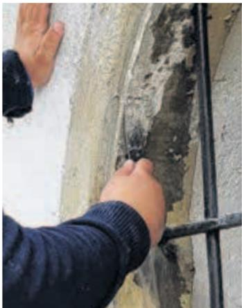
Der Spezialist trägt am Wasserradhaus eine Lauge auf, damit die Farbe auf dem Sandstein entfernt werden kann.
