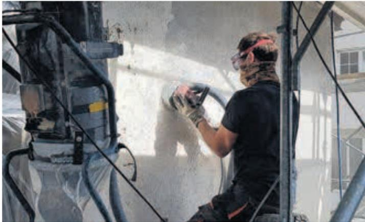
Abschleifen der Fassade, später wird dann ein neuer Kalksteinputz angebracht. Bilder zvg
