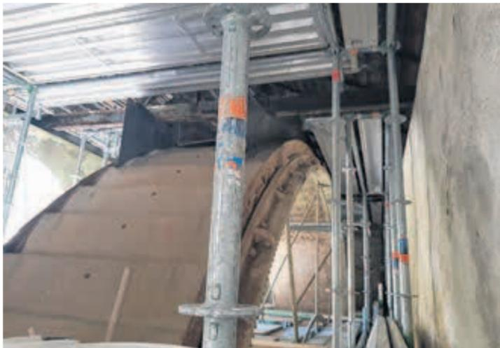
Der Rost wird von den Schaufeln des Wasserrads abgebürstet und diese später konserviert.
