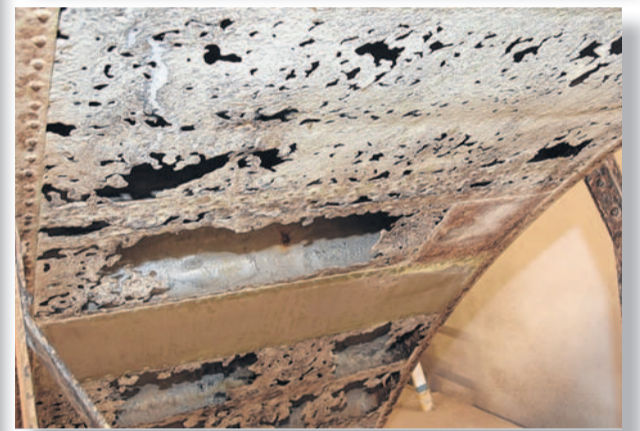
Eine erste Etappe der Renovation des Wasserrads in der Neumühle in Wollerau ist abgeschlossen. In einem nächsten Schritt muss mehr als die Hälfte der Schaufeln ersetzt werden, weil sie durchgerostet sind.
