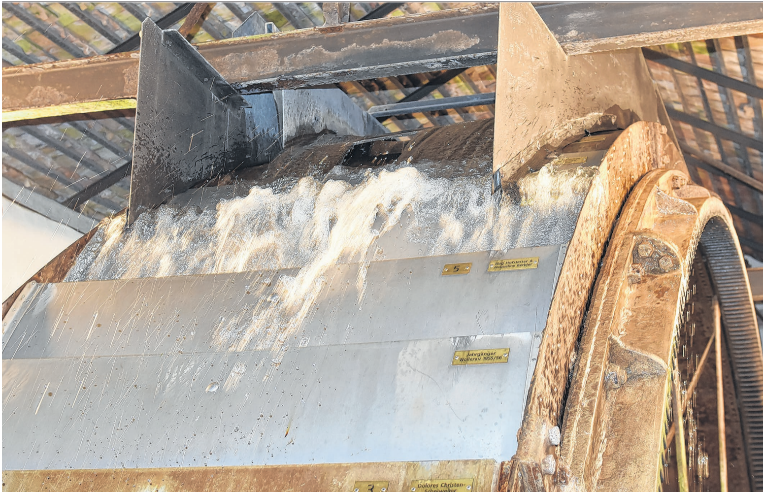
Die Schleuse wurde geöffnet und das Wasserrad in Betrieb genommen.
